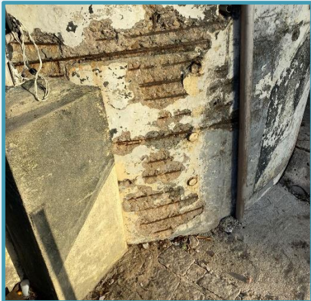
Armadura aparente
