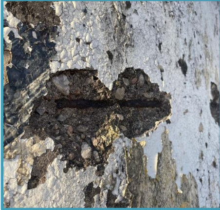
Armadura aparente
