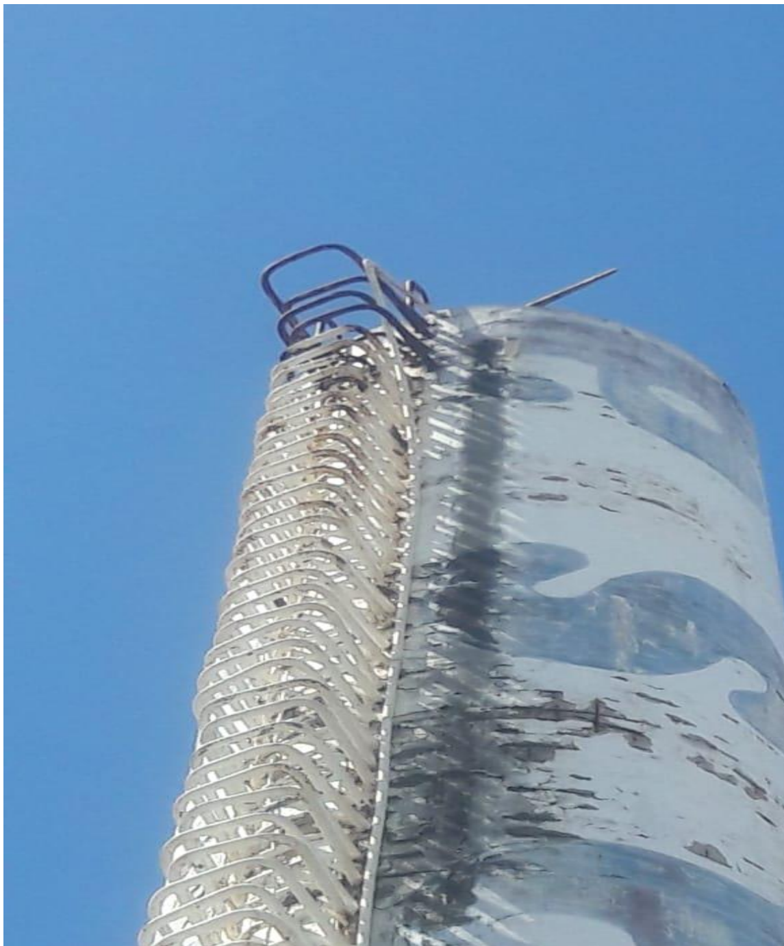
VISTA DO RESERVATÓRIO E DESTAQUE DA ESCADA MARINHEIRO
